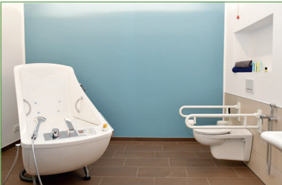
Wer gerne badet, kann diese besondere Sitz- und Liegebadewanne nutzen. Der Einstieg ist über die seitliche Flügeltür möglich oder über einen Lift.
