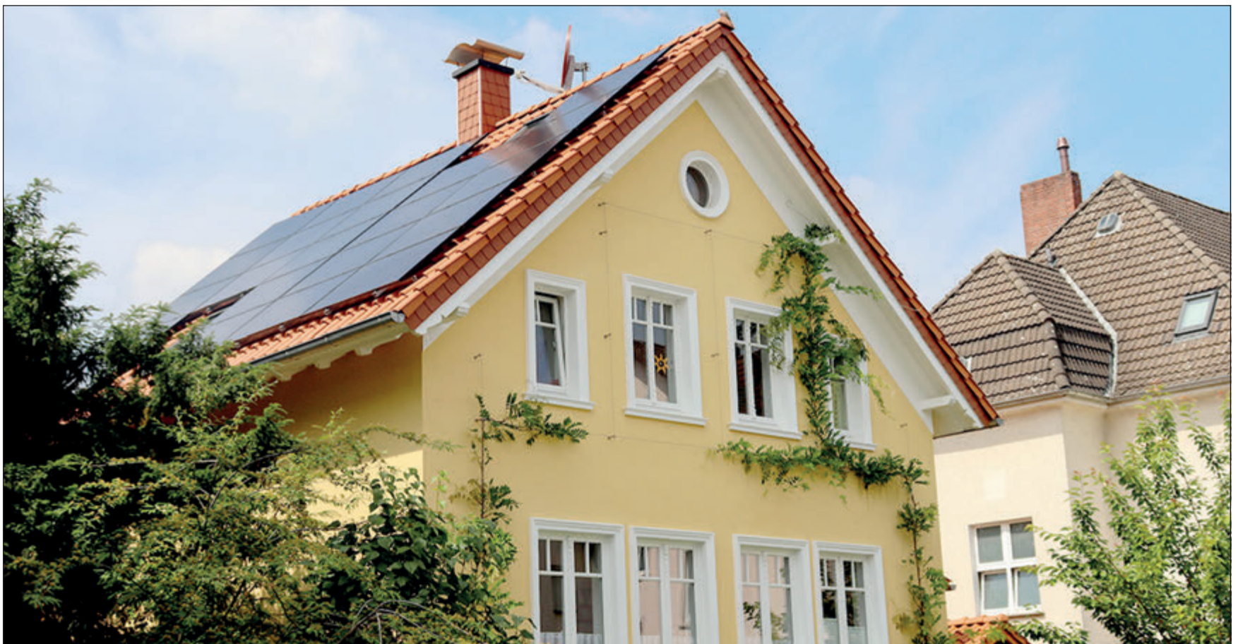
Frisch herausgeputzt, mit doppeltem Wärmeschutz: Eine Fassadenmodernisierung stellt eine gute Gelegenheit dar, gleichzeitig die vorhandene Dämmung zu verstärken. Foto: DJD/VDPM/finecki - stock.adobe.com
